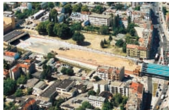
Weiterbau der A 100
