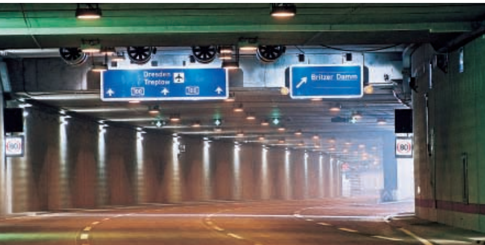
Tunnelausfahrt Britzer Damm
