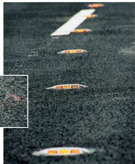
Unterflurleuchten in LED-Technik verdeutlichen eine geänderte Streckenführung
