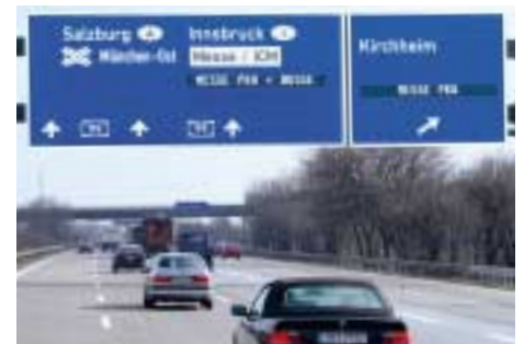
Wechselwegweisung für Messeverkehr ohne Standstreifenfreigabe
