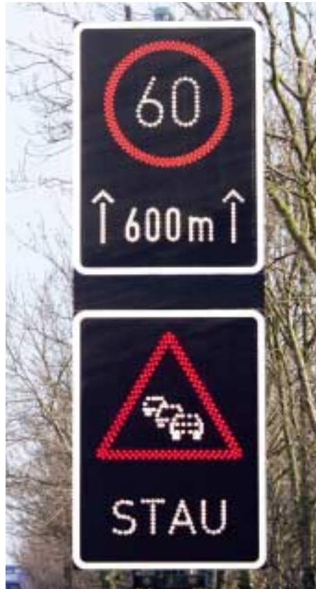
Wechselverkehrszeichen in seitlicher Aufstellung
