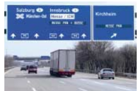
Wechselwegweisung für Messeverkehr mit Standstreifenfreigabe
