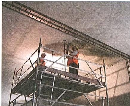
Montage Brandschutzplatten an Tunneldecke
